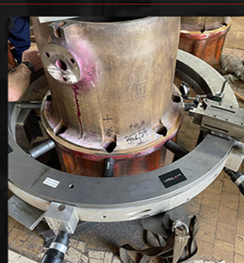
USINAGE D'UNE PORTÉE D'ENVELOPPE Machining of a seal surface
